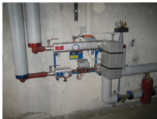
Wärmetauscher, Zähler
