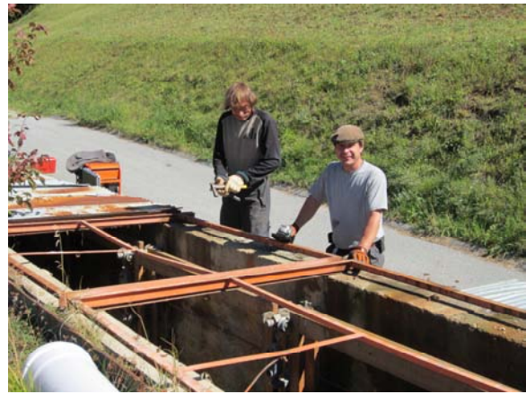
Die Gemeindearbeiter Abraham Briw und Daniel Minnig reparieren das Blechdach des Scheibenstands.
