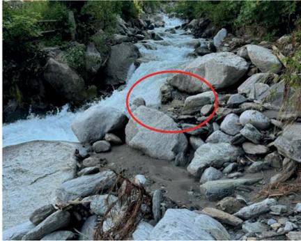
Beschädigte Fassung der Wuhr (rot) mit grossen abgelagerten Steinen. Foto: geoformer igp AG 18.07.2024
