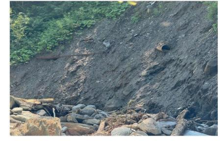
Beschädigtes Rohr wenige Meter unterhalb des Sandfangs. Fliessrichtung von links nach rechts im Bild.
