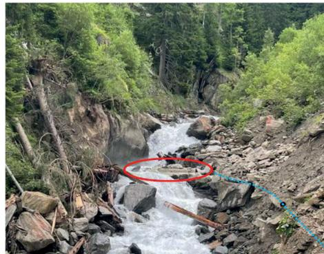
Fassung der Trusera (rot), die seitlich umflossen wird. Die einbetonierte Leitung (blau gepunktete Linie) wurde grösstenteils weggerissen.
