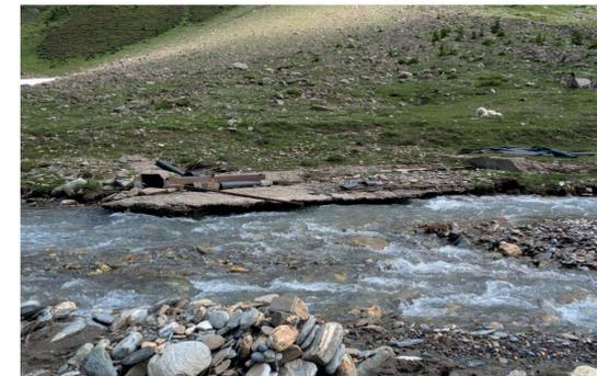
Unterspülte Leitung der Putzera. Fassung und Entsander sind nicht mehr sichtbar. Fliessrichtung von links nach rechts im Bild. Foto: F. Schwery
