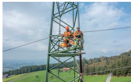
Von Frühling bis Herbst 2025 wird die grüne Farbe an den Strommasten mit dem definitiven Farbton übermalt (zweite Farbschicht)
