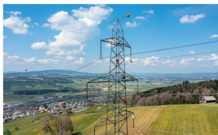
Von Frühling bis Herbst 2025 wird die grüne Farbe an den Strommasten mit dem definitiven Farbton übermalt (zweite Farbschicht)
